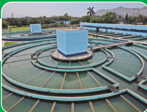
Canalización Eléctrica para Sedapal - La Atarjea Infraestructuras Eléctricas
